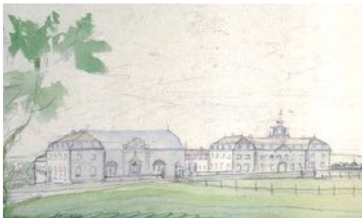
'Der Bau' met bijbehorende boerderij, de Cereshoeve. Gebouwd als woning met fabriek en hoeve voor de naaldenfabrikant Jacob Kuhnen.
